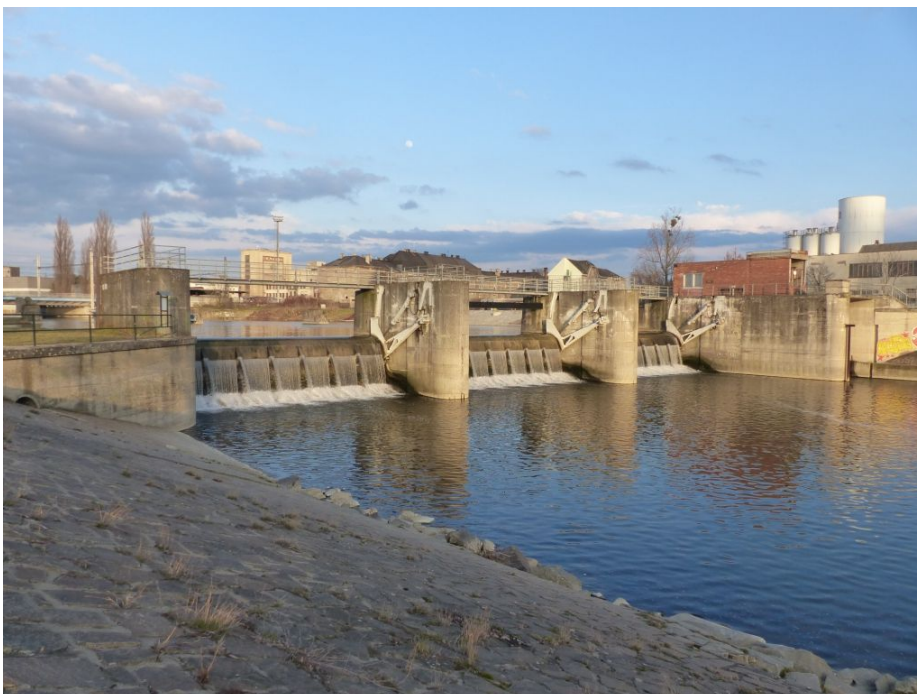
Obr. č. 9: Jez Přerov (zdroj: Tomáš Kolařík)
