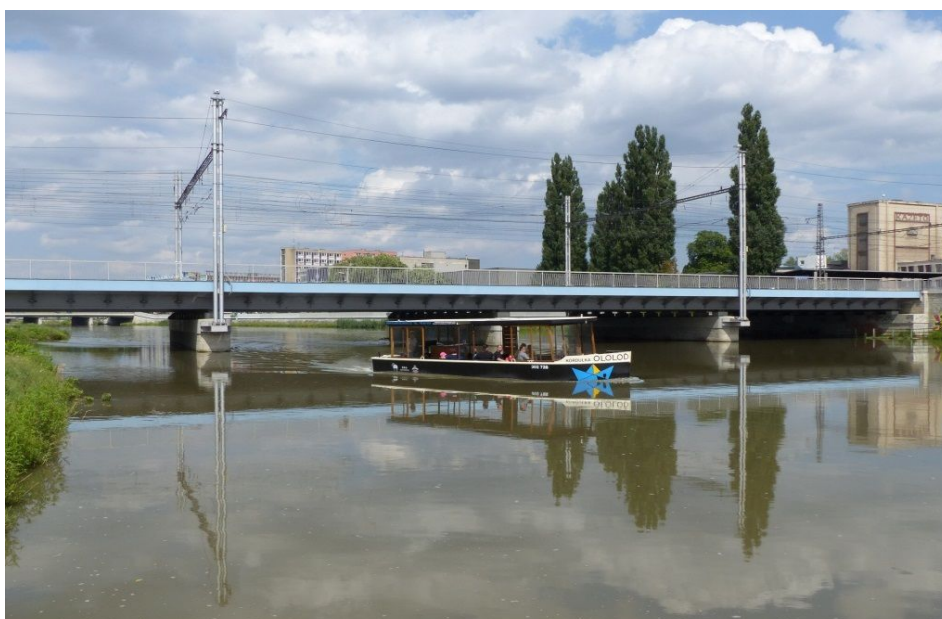
Obr. ř. 45: Źelezniční most pıes řeku Bečvu v Píerově má dostatečnou podjezdnou výšku pro rekreační a osobní plavbu (zdroj: Tomáš Kolařik)
