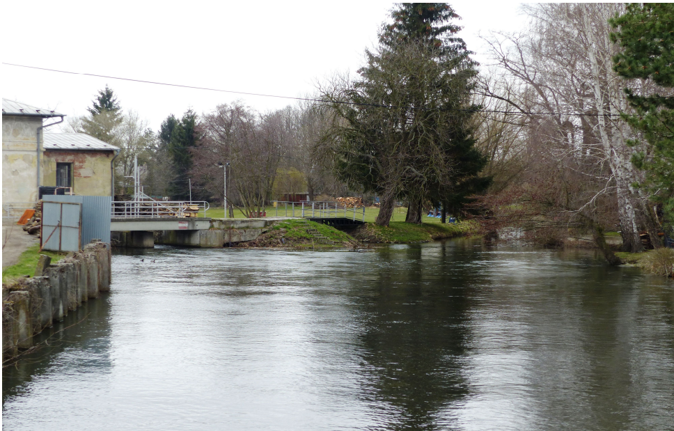
Obr. č. 37: Mlýnský náhon v Lobodicích (zdroj: Tomáš Kolařík)
