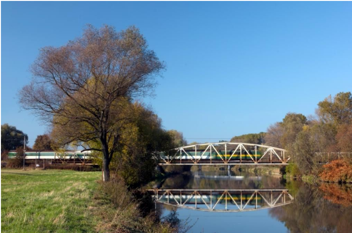
Obr. č. 36: Železniční most přes řeku Moravu u Kojetína
