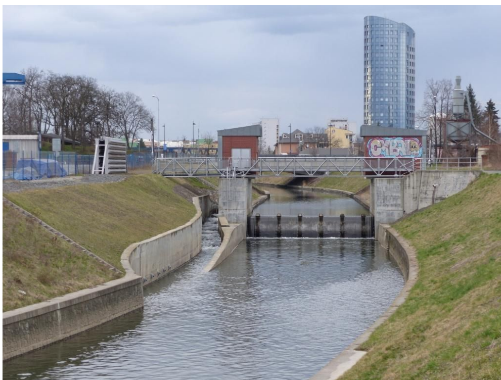
Obr. č. 46: Jez na protipovodňovém obtokovém kanále v Olomouci. Pro překonání jezu je potřeba vybudovat plavební zařízení (zdroj: Tomáš Kolařík)
